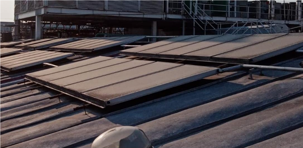
Ilustración 26 Arranque sistema fotovoltaico
