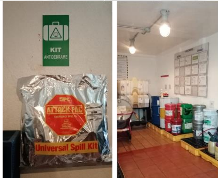
Fuente. Imágenes reales de las instalaciones de la empresa, 2025
